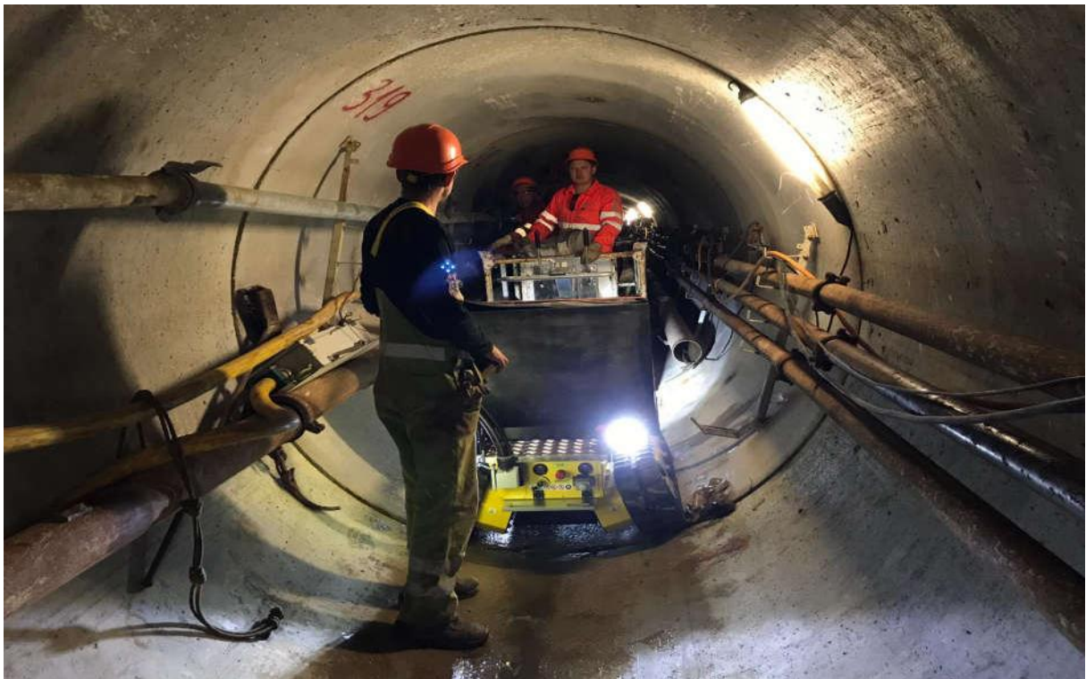
Foto 8 DCT450MT in actie in de microtunnel
