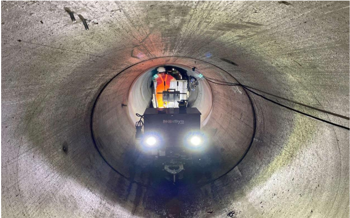
Foto 7 DCT450MT in actie in de microtunnel
