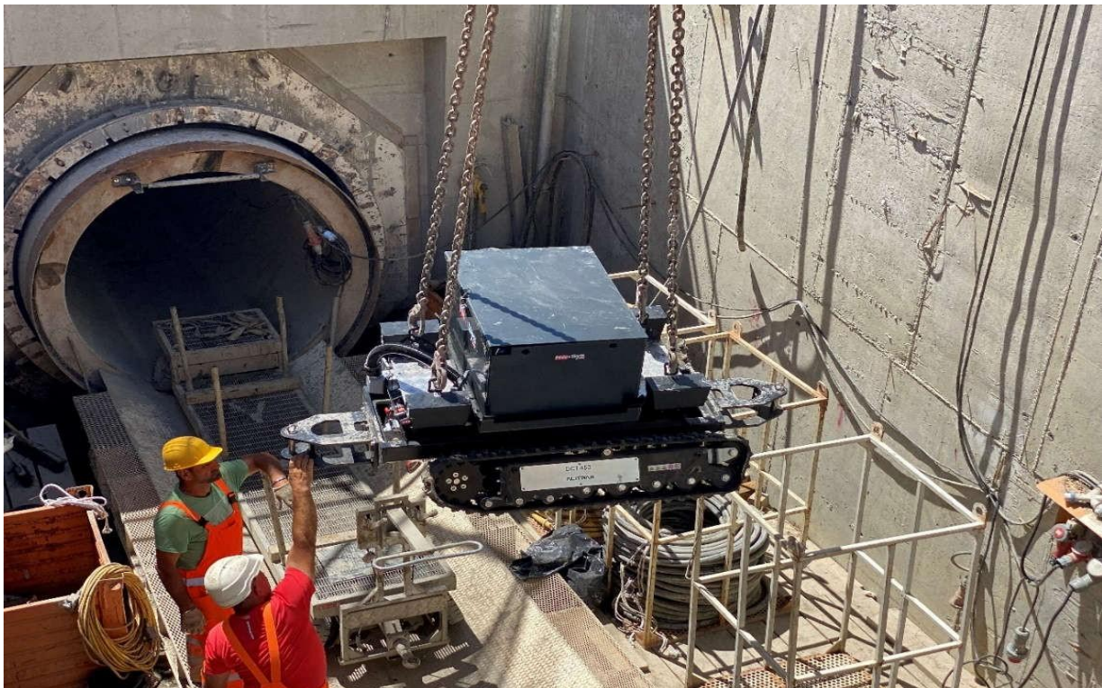
Foto 5 Het laten zakken DCT450MT in de werkput
