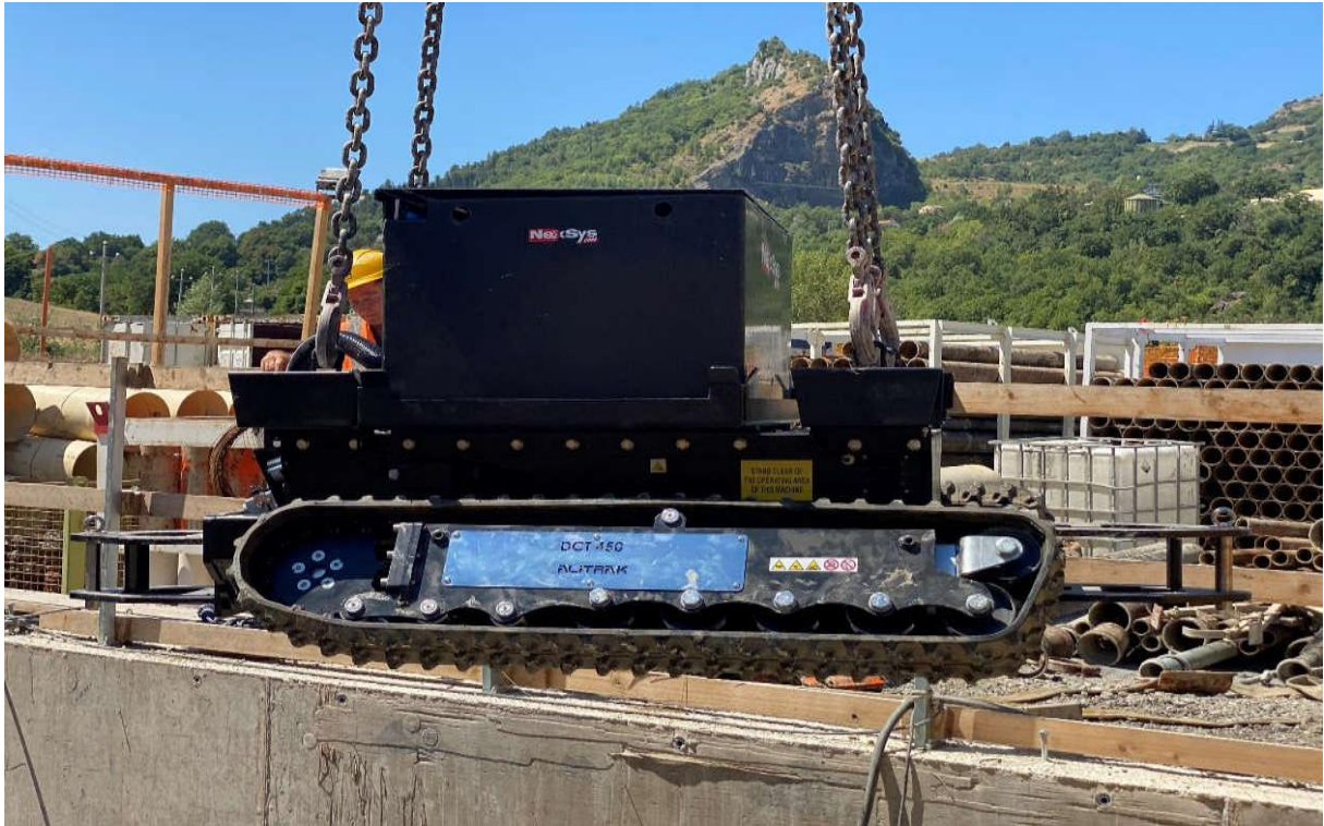
Foto 4 Het laten zakken DCT450MT in de werkput
